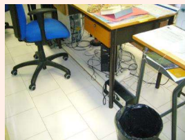
Foto n. 1 cattivo cablaggio
